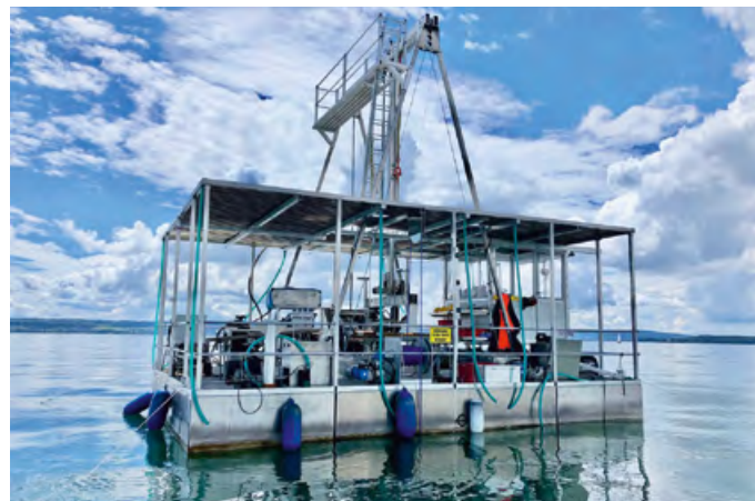
Der Bohrhammer wird von einer kompakten, schwimmenden Plattform aus betrieben.
