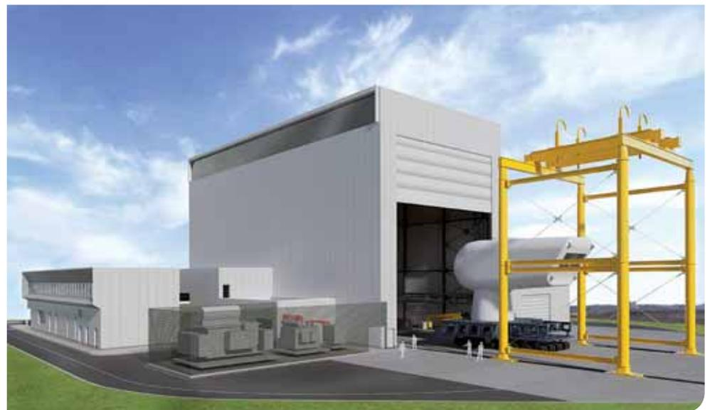
In der 30 Meter hohen Halle des DyNaLab werden Gondeln in Originalgröße geprüft. © Fraunhofer IWES
