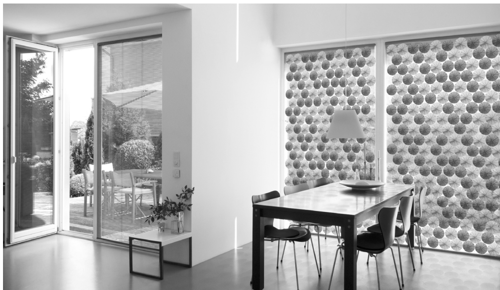
Das Fassadenelement benötigt keine externe Stromversorgung. Es funktioniert auf Basis von integrierten Drähten mit Formgedächtnislegierung. (© Wilm Ihlenfeld/Fotolia, Fraunhofer IWU) | Bild in Farbe und Druckqualität: www.fraunhofer.de/presse
